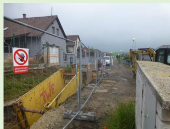
Odkanalizování nemovitostí za humny
